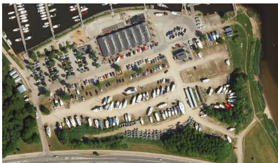
Figur 03.7 Parkering i eksisterende lystbådehavn (Kilde: Miljøportalen).
